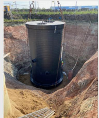
Auftriebssicher und schneller betriebsbereit auch bei hohen Grundwasserständen
