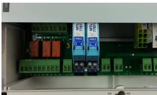
Abb. 2 Stück Zenerbarrieren in 1-Pumpen - ohne Trennplatte -
